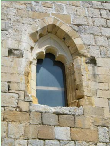
Particolare. Finestra della torre principale
