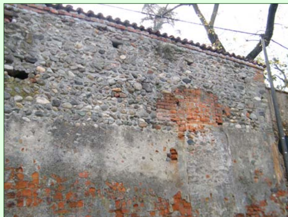
Tessuto murario del borgo di Caluso di origine Tre-Quattrocentesca. Foto di Katia Somà. 2011
